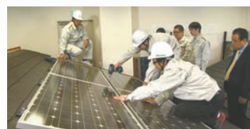
施工技術研修
